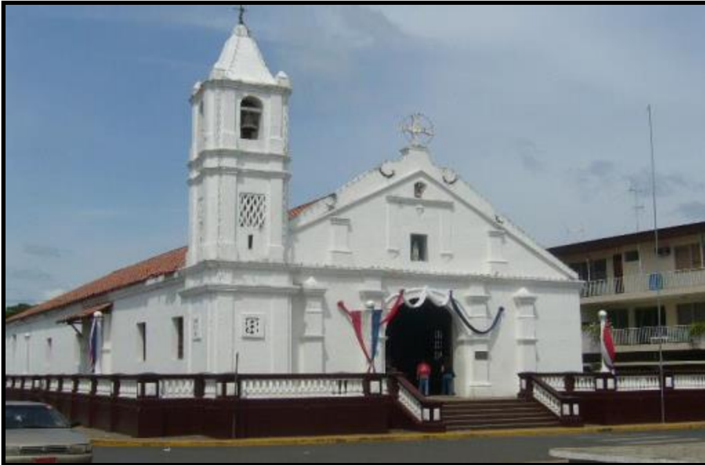
Iglesia de Santa Librada en la ciudad de Las Tablas.
